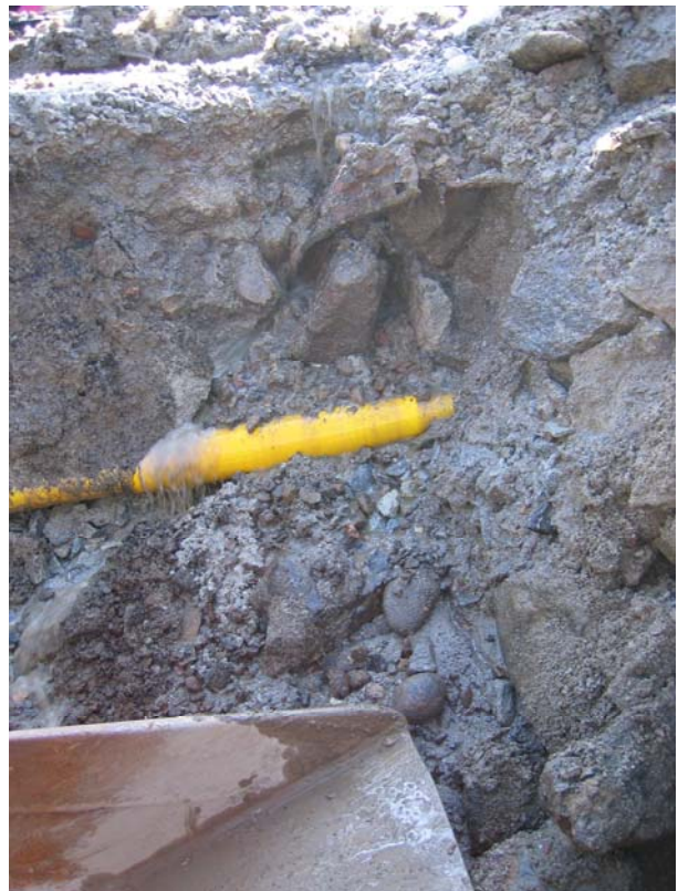
Figur 4: Ledning i gropens södra del
